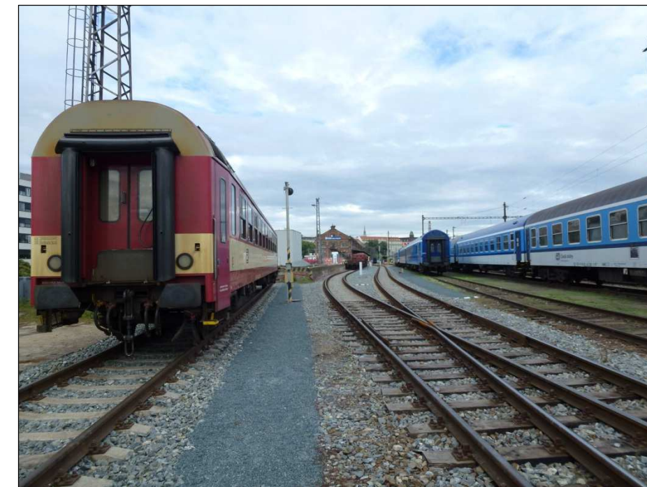
Obrázek 47 - Odstavné koleje v železničním uzlu Brno
