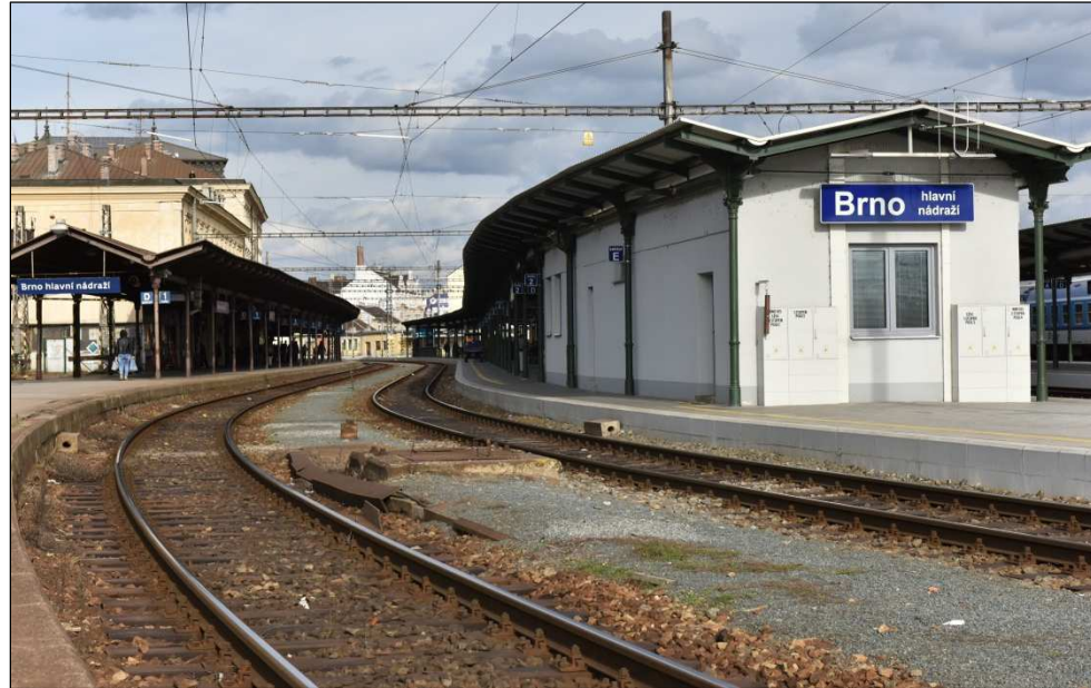
Obrázek 48 - Koleje s nástupišti na hlavním nádraží
